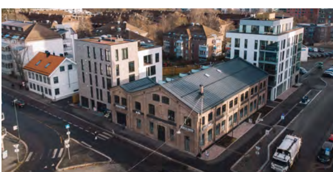
Boliger og dagligvare i kombinasjonsprosjekt på Bjølsen, Arcasa Arkitekter
