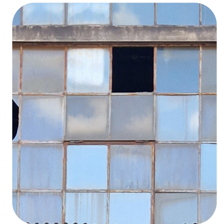
Smårutet vindu (bilde av eksisterende vinduer)
