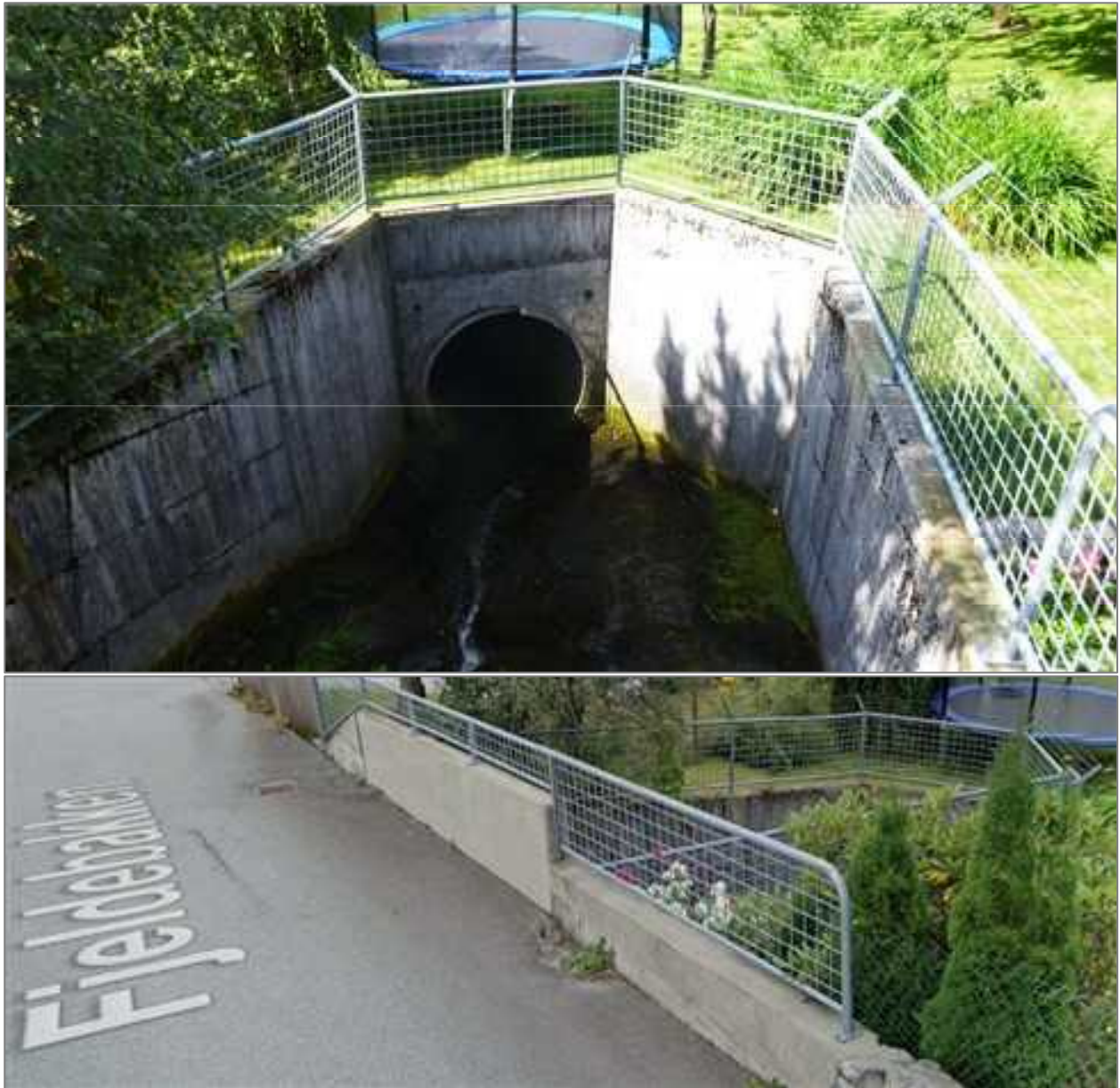
Figur 9.43 Inntak 22159 på Fjeldebakken. Nedre bilde fra GoogleStreetView.
