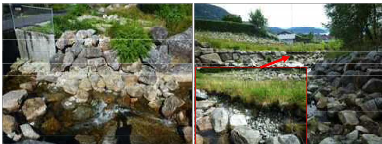
Figur 9.48 E 5 – Skardbekken, høyre bredd ved Snøklukkevegen (venstre). E 6 – Skardbekken ved Bergflettevegen, sidesikringen har rast ut på venstre bredd (høyre).
