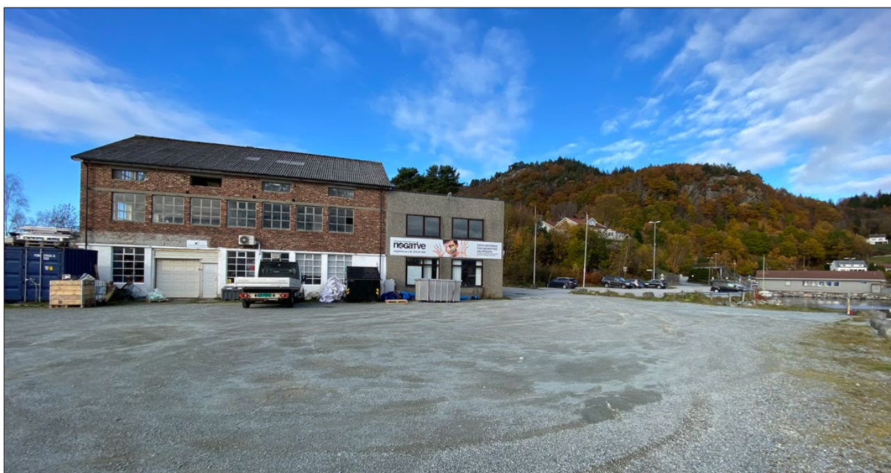
Figur 5-3: Eksisterende bygninger i bakkant av gruset flate etablert på sjøfylling. Foto: Multiconsult
