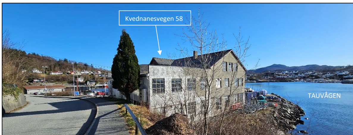
Figur 3-2: Bilde av Kvednanesvegen 58 med omgivelser sett fra vestsiden av planområdet og mot øst. Foto: M. Bjerga, Multiconsult.
