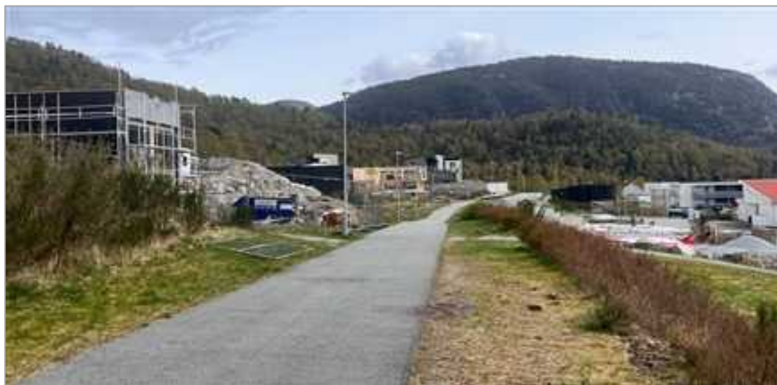
Figur 18 Tursti mellom Fullshammarvegen og Rubinvegen er asfaltert der det er etablert ny bebyggelse
