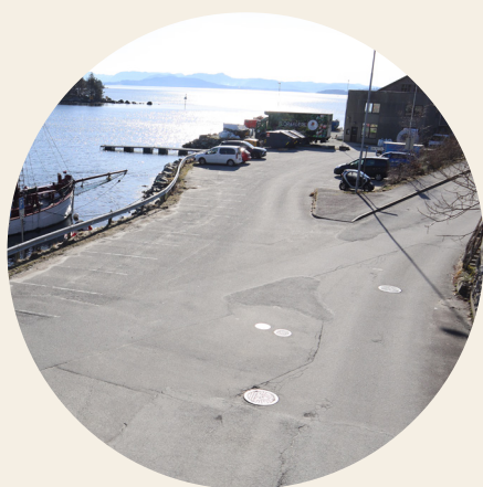
Innkjørsel til planområdet er uoversiktlig for gående
