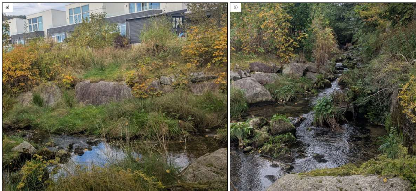
Figur 14 Bildene viser bekk med drenering gjennom kartleggingsområdet gitt ved a) steinsatte og erosjonssikre bredder og b) stabilt løp med grov stein. Fare for erosjon vurderes som fraværende. Bildelokasjoner er avmerket med henholdsvis 2 og 3 i Figur 10. Bilde: Skrið Aktsomhet.
