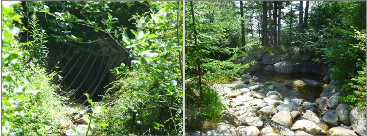
Figur 9.31 Inntak i Otervegen (venstre) og massebasseng ved enden av Granittvegen (høyre).
