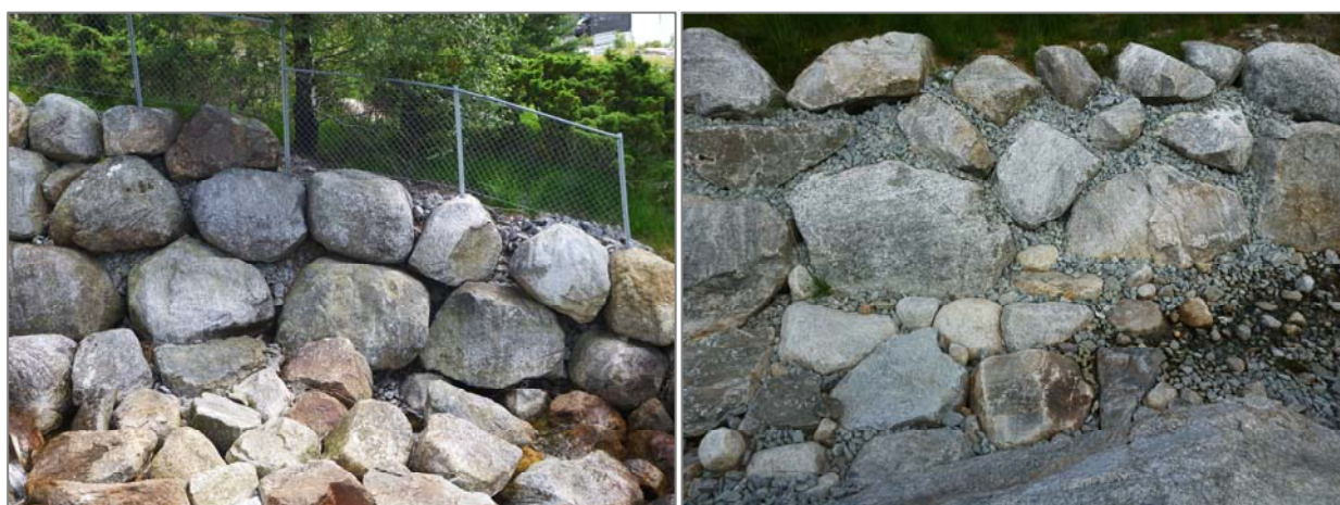
Figur 9.49 E 7 – Skardbekken, venstre bredd nedstrøms gangbrua på Rubinvegen (venstre). E 8 – Skolebekken, høyre bredd nedstrøms gangbrua ved Gaupevegen (høyre).
