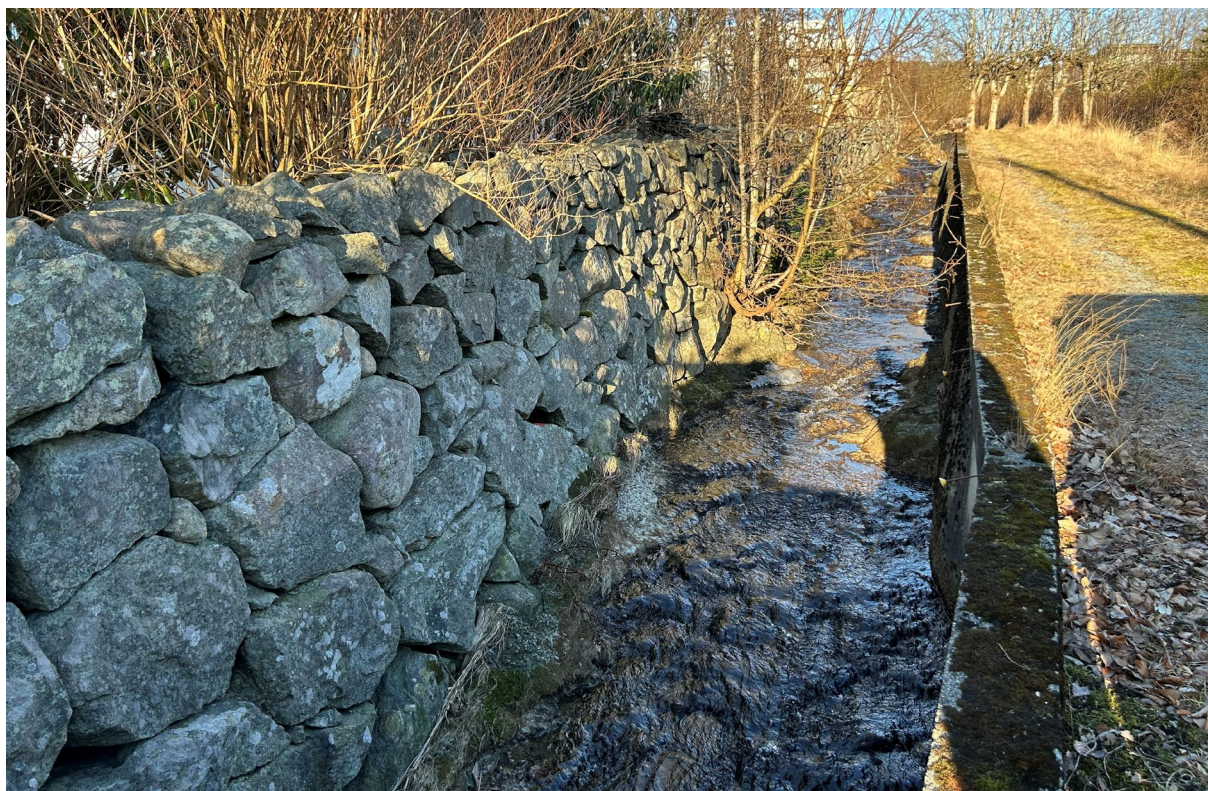
Figur 9 - Bildet viser kanalisering av bekkens nedre parti med lødd mur på vestsiden og støpt mur på østsiden
