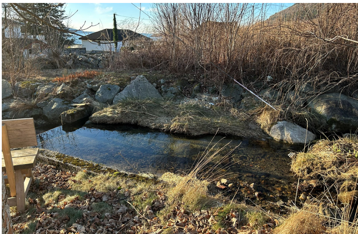
Figur 8 - Bildet viser fangdammen sett ovenfor terskelen
