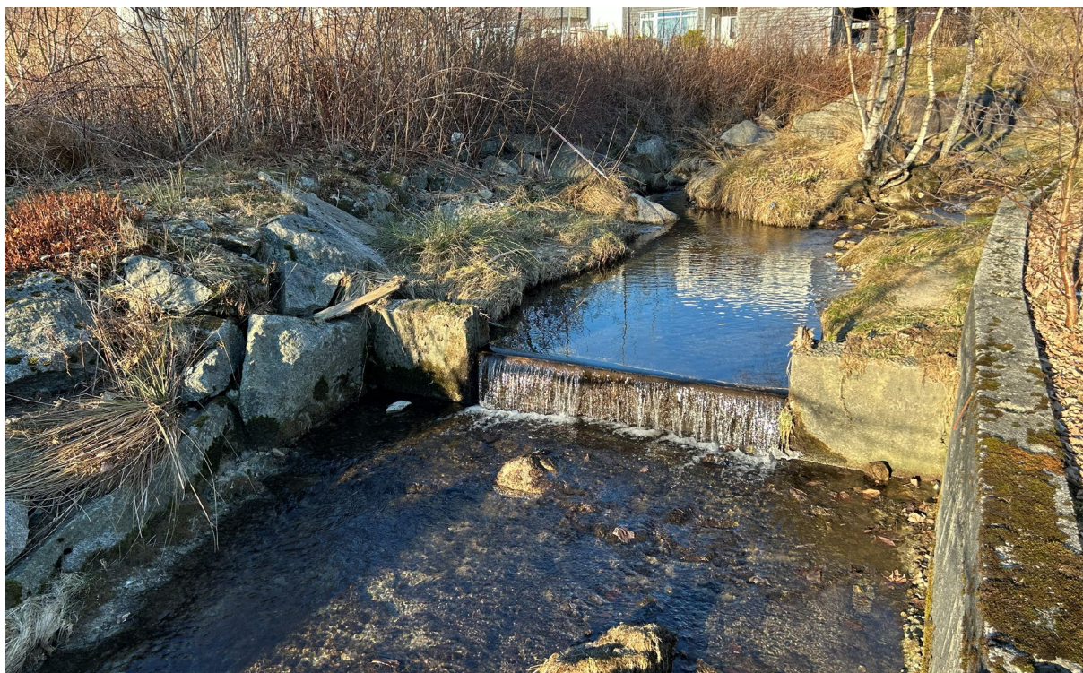
Figur 7 - Bilde viser etablert terskel og fangdam i bekken
