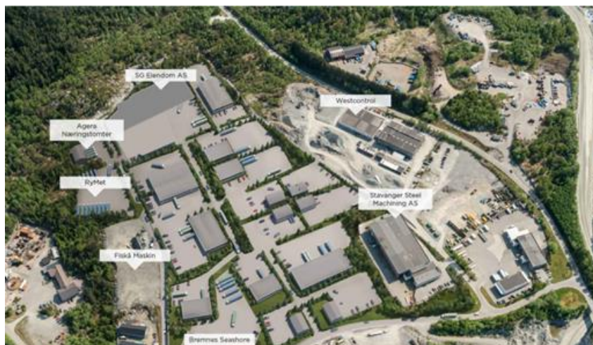
Figur 7: Mulig utvikling av Tau næringspark uten hydrogenanlegg (0-alternativet). Kilde: hjemmesiden til Tau næringspark.
