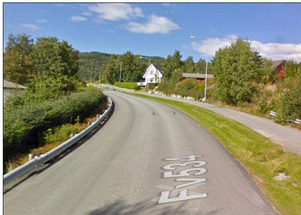
Figur 5-5. Gang- og sykkelveg i Hellandsvegen som blir adkomst for kjørende.
