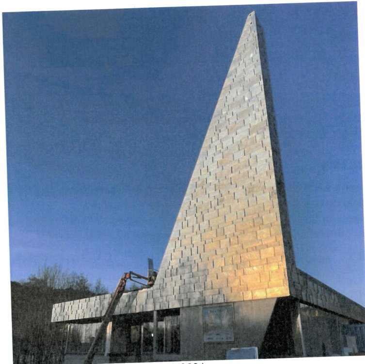
Figur 2 - Utvendig status- Januar 2021
