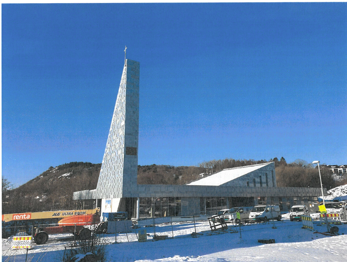
Bilete av Tau kyrkje 13. januar 2021. Korset blei montert 11. januar.
