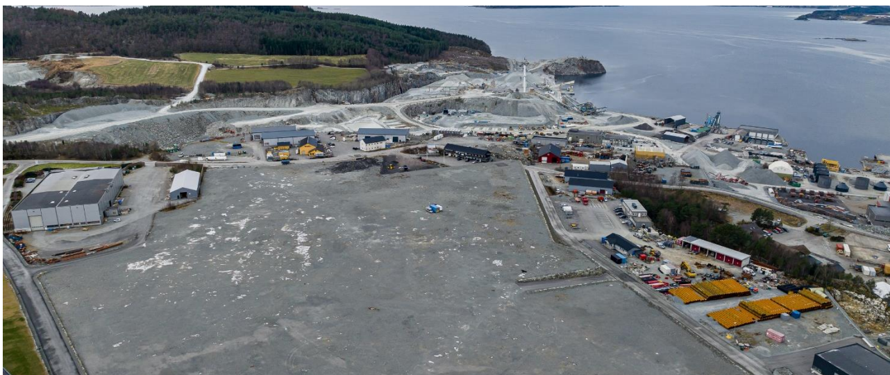
Figur 10: Dronefoto av Tau næringspark, datert 29.11.23. Tatt mot vest.
