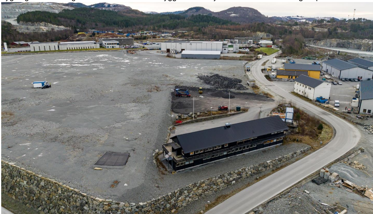
Figur 13: Eksisterende bygg på tomte som reguleres for hydrogenanlegg. Dronefoto 29.11.2023.
