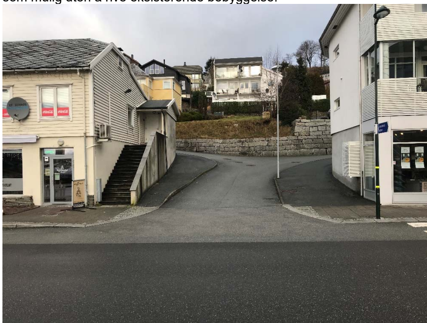
Bilde 1-5 Vegen er lagt til venstre for å øke sikten så mye som mulig for de som kommer inn mot krysset fra høyre.
