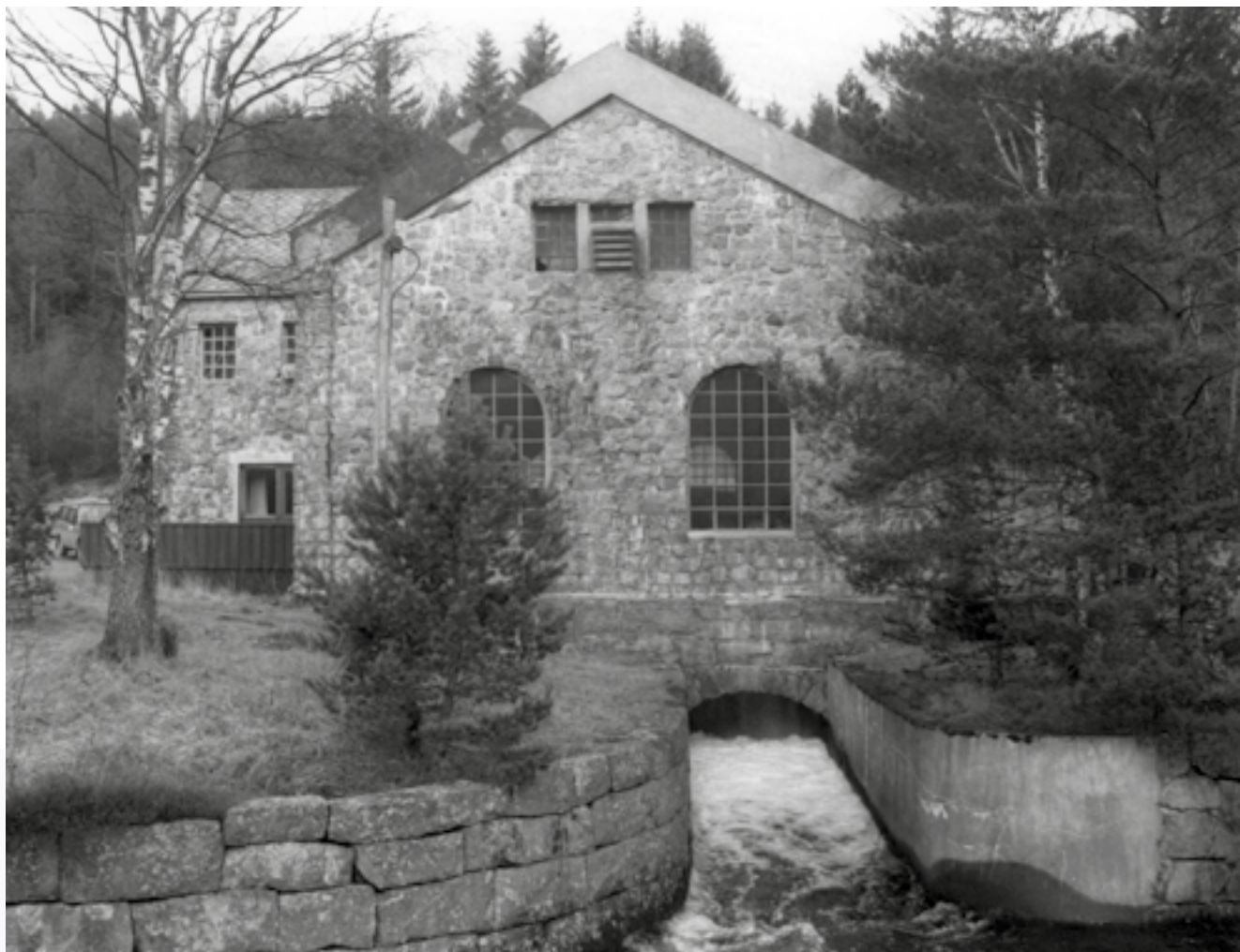
Kraftstasjonen i Dalen
