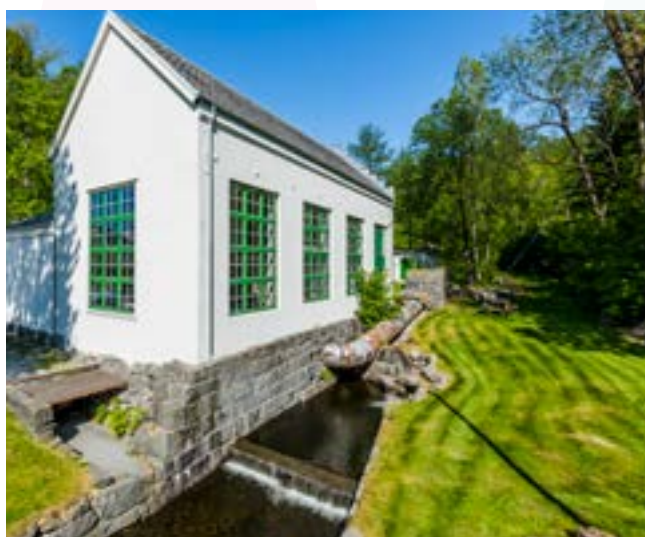
Kraftstasjonen på Jørpeland
